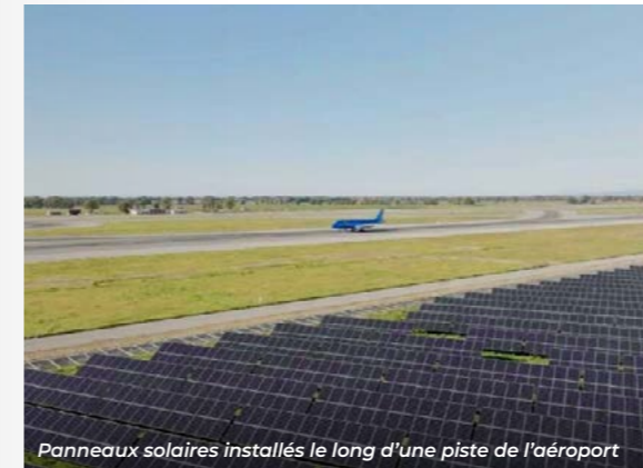
Panneaux solaires installés le long d'une piste de l'aéroport
